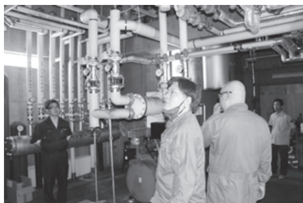
▲現況調査の様子
