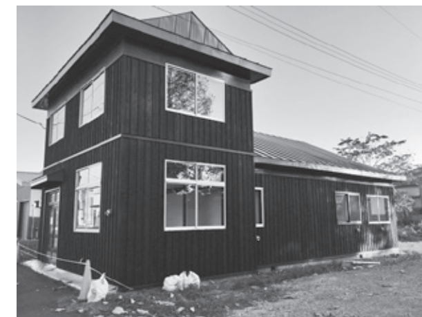
▲民泊へ改装中の空き家
