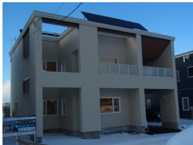
住宅の太陽光発電を設置した住宅2棟の中央に地中熱ヒートポンプを設置
