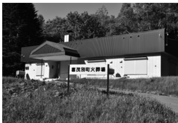
喜茂別町火葬場
