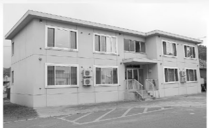
外観(1階部分が宿泊所)
