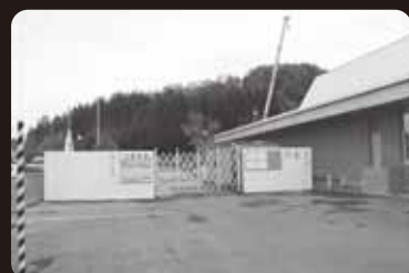
建設中の京極町給食センター
