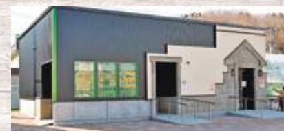
トイレ・インフォメーション施設
