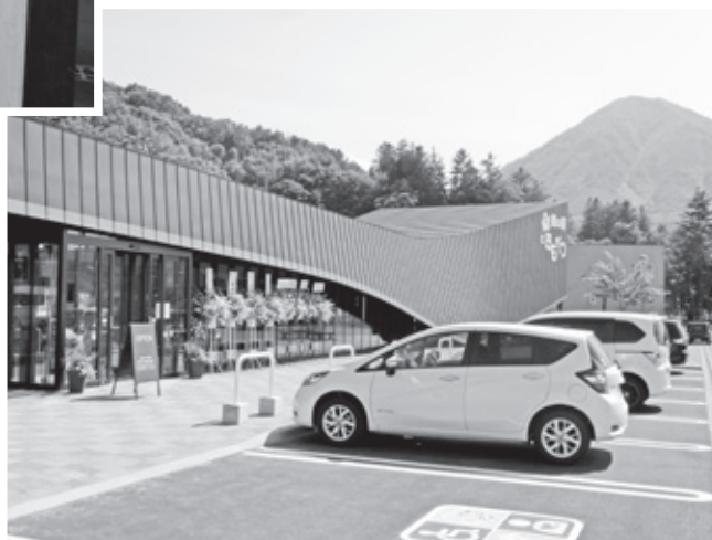
改修工事後の郷の駅外観
