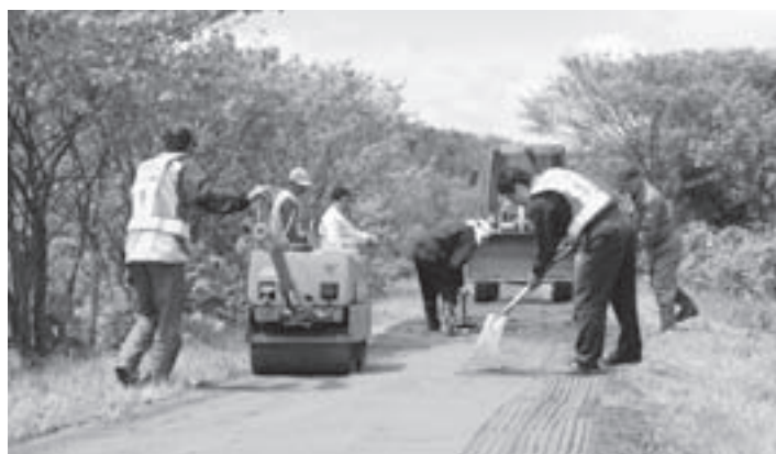
町民有志によるウォーキングロード整備
