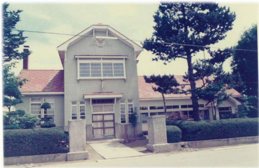
【旧局舎（昭和16年建設）】
